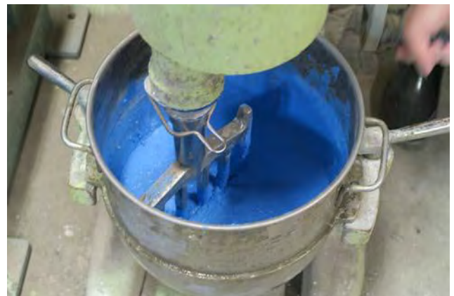
写真 2 カラーモルタルの練混ぜ状況
